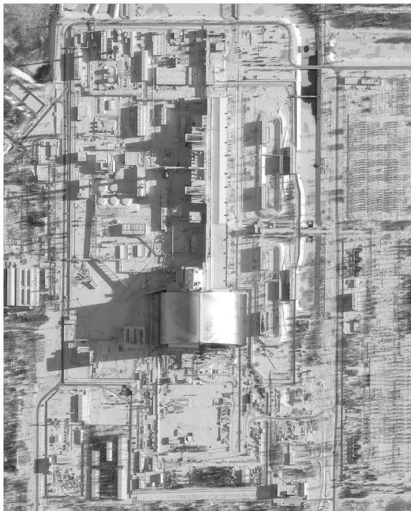
L'arche installée sur le réacteur 4 de la centrale de Tchernobyl. Image acquise par le satellite Pléiades en décembre 2016.
